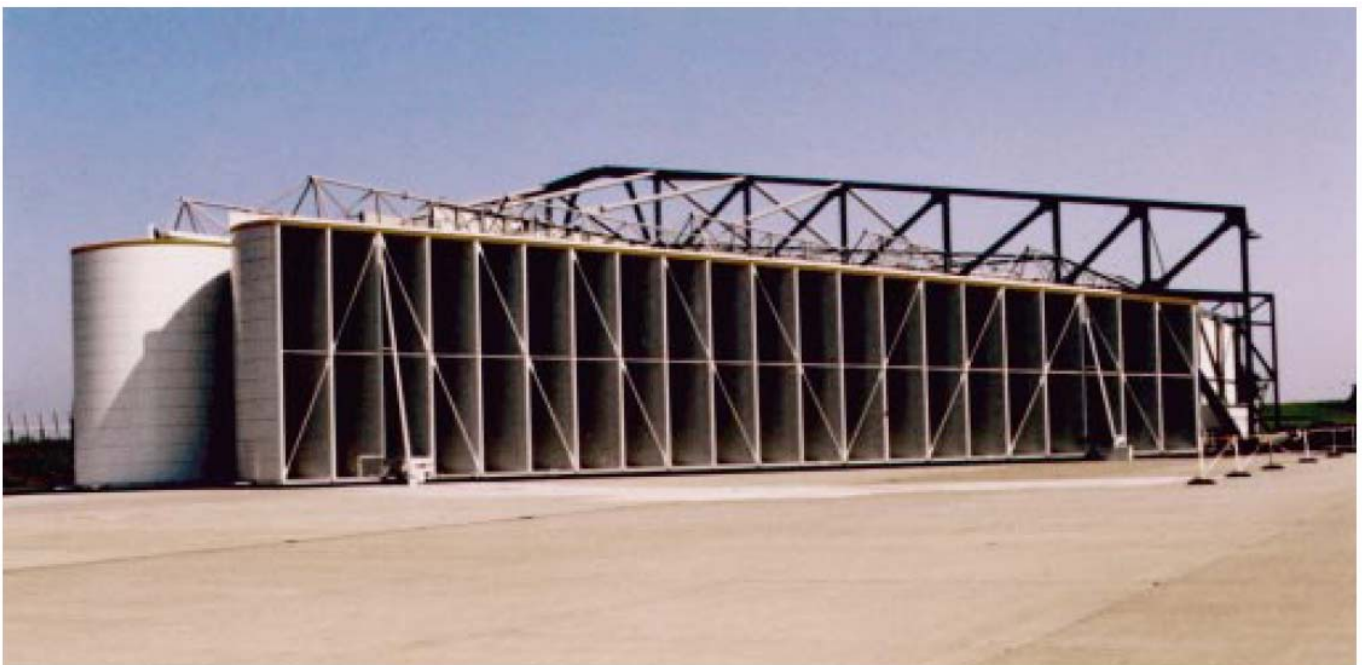
Öffenes Tor mit Schalldämpferkulissen für Lärmschutzhalle
